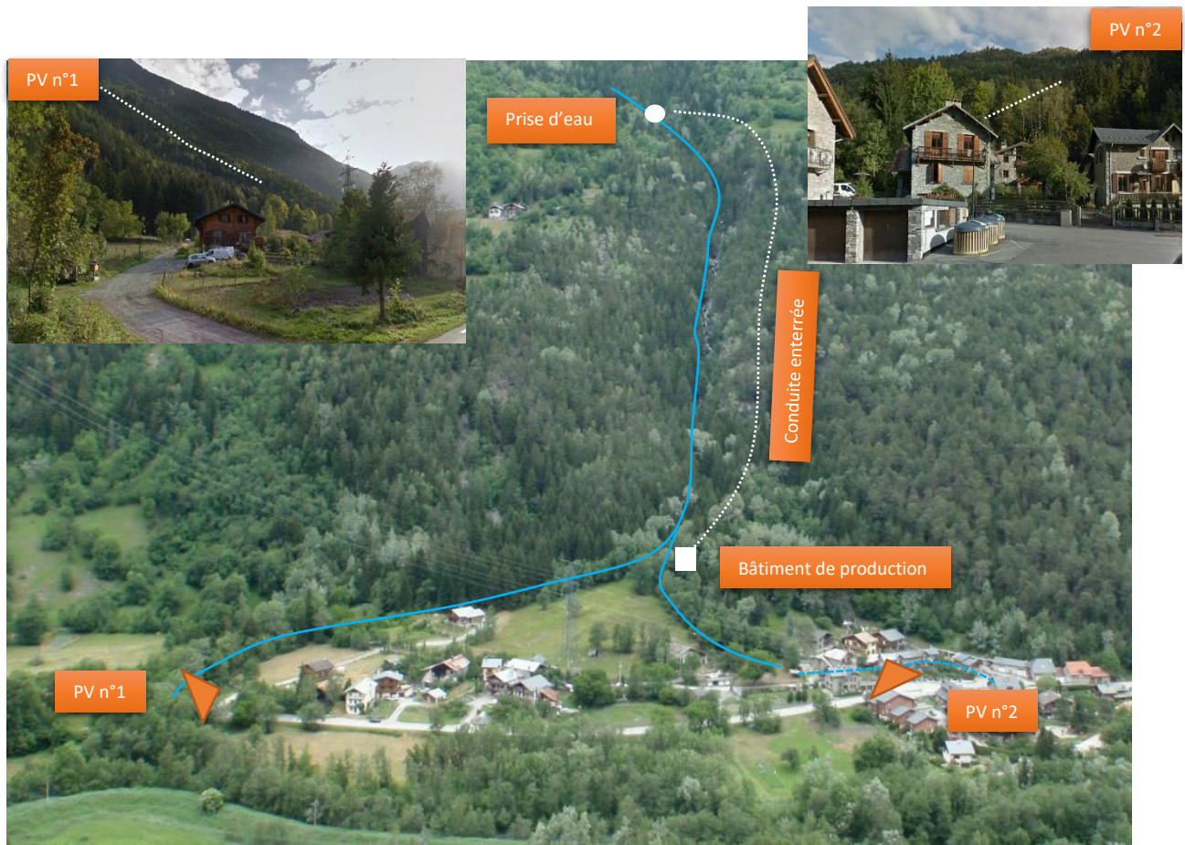
Figure 77 : Perceptions de la conduite enterrée depuis le hameau de Viclaire.
