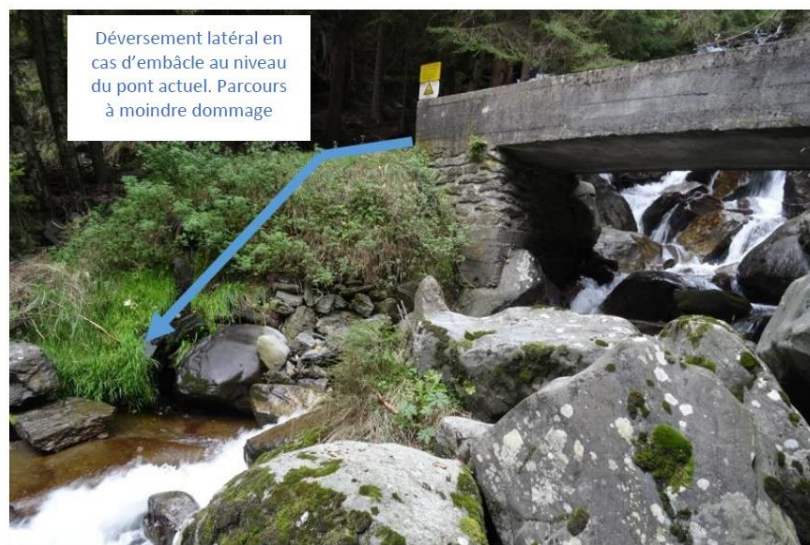
Figure 62 : Visualisation du parcours à moindre dommage.
