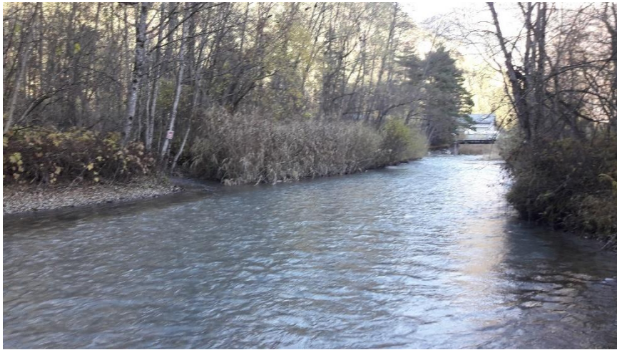
Figure 84 : La Petite Isère en aval du pont de Viclaire.
